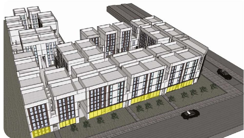
Ilustración 2 Proyecto habitacional Patios de Copiapó, ubicado en Copiapó N°345, Santiago, 84 viviendas sociales. Este proyecto cuenta con más de 340 m 2 de equipamiento municipal en primer piso y se inaugurará durante el 1er semestre de 2023.
